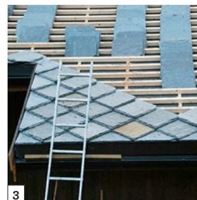
3/4. Montering av Otta firkantstein på hyttetak. Installation of Otta square schist on a cabin roof.
