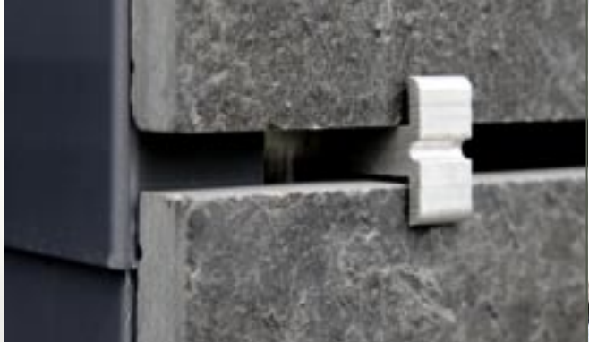
Detalj av opphengssystem for fasadeplater.
