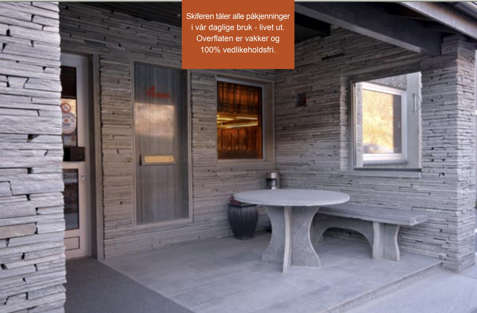
Fasade i tørrmur (hugget kant), flis, bord og benk i Minera Skifer Oppdal.
