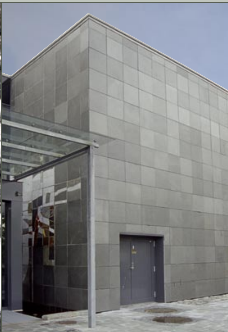
Fasadeplater i Minera Skifer Alta.
