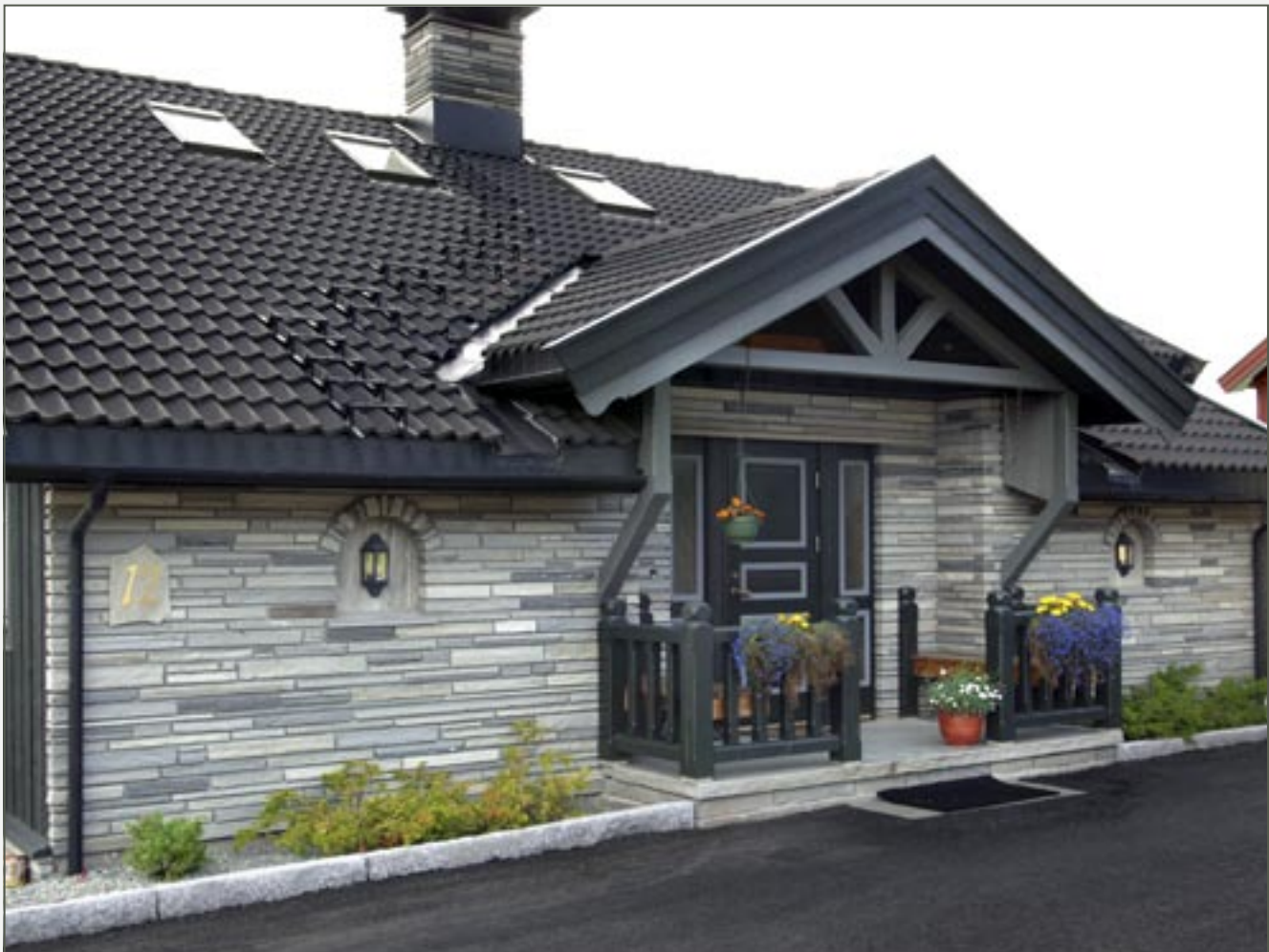
Fasade i murstein fra Minera Skifer Oppdal.
